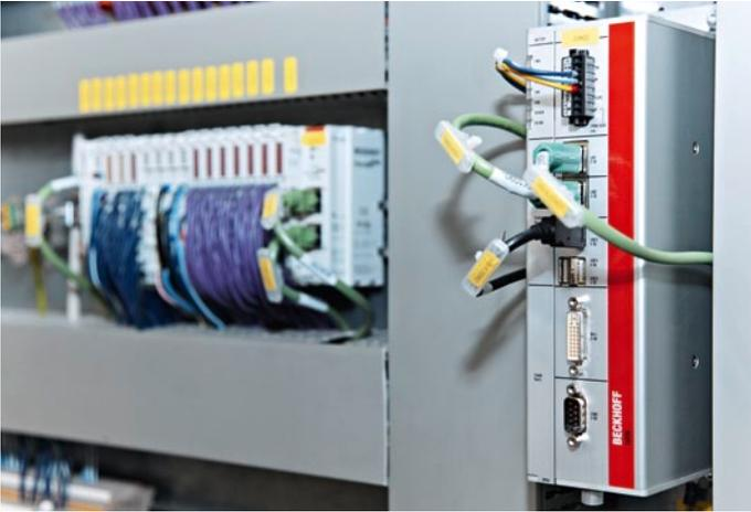
Der kompakte Schaltschrank-IPC C6920 bietet mit seinem Dual-Core-Prozessor ausreichend Leistung sowohl für die Heizzone- als auch für die Wanddickensteuerung.
