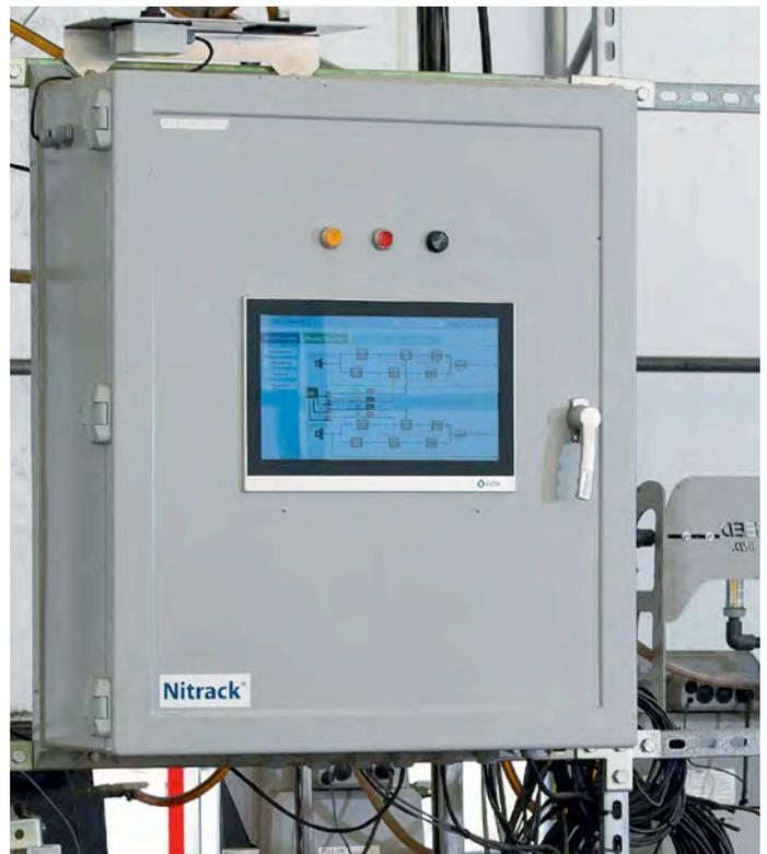
Nitrack® von EOSi nutzt als erstes System seiner Art die PC-basierte Steuerungstechnik für die Überwachung des biologischen Nährstoffabbaus in der Abwasseraufbereitung.
