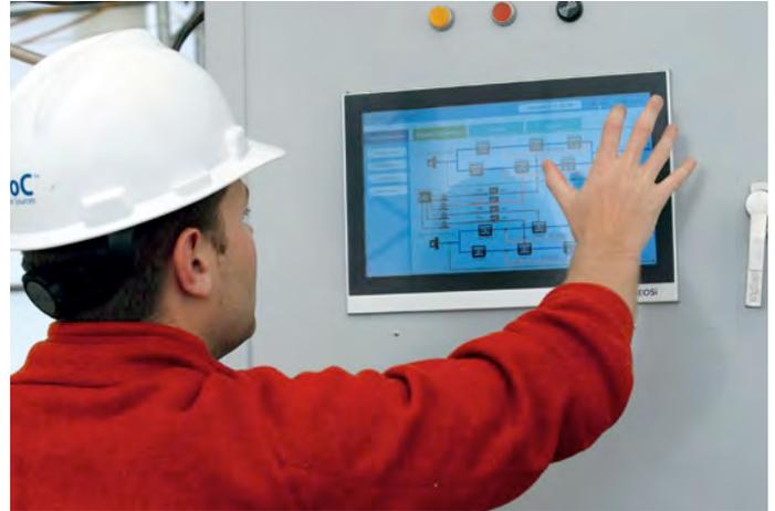
Auf dem Multitouch-Panel-PC CP2216 von Beckhoff läuft die HMI-Software von EOSi und die Steuerungssoftware TwinCAT.
