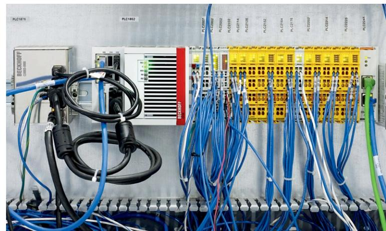
Ein leistungsfähiger Embedded-PC CX5140 sorgt – platzsparend im Schaltschrank mit angereicherten EtherCAT- und TwinSAFE-Klemmen untergebracht – für schnelle Steuerung und hochgenaue Synchronisation.
