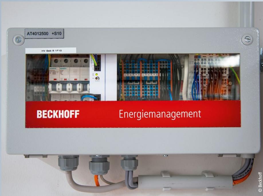
Mit kompakten Embedded-PCs und Energiemessklemmen werden die Energieverbräuche in der Produktion erfasst.
