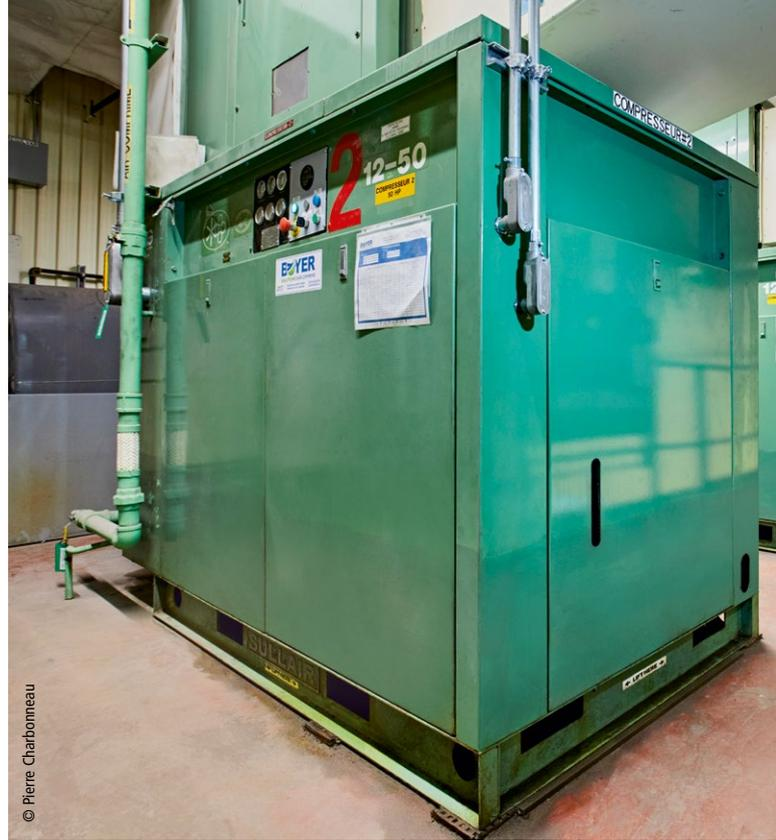
EtherCAT-Kommunikation bindet verschiedenste Geräte wie z. B. die Kompressoren in die Anlage ein.
