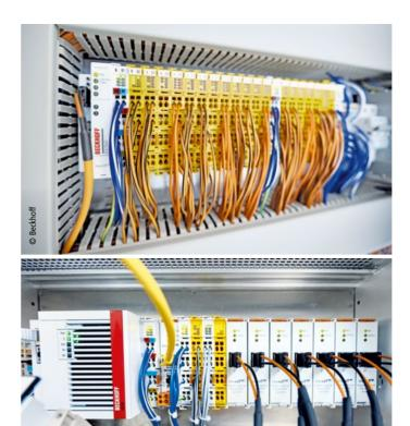
Oben: Bei den hohen Spannungen und Strömen hat Sicherheit oberste Priorität: Über TwinSAFE-Klemmen für mehr als 620 Safety-relevante Kanäle wird die Anlage
