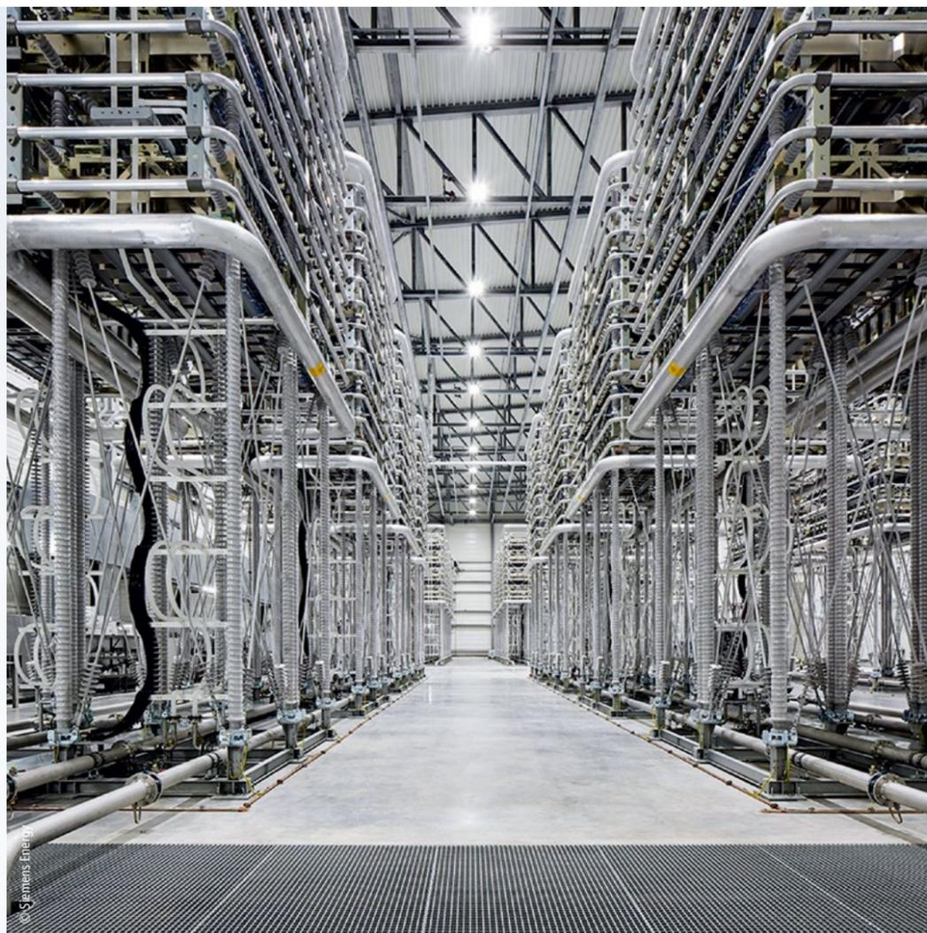
Anlage zur Hochspannungs-Gleichstrom-Übertragung
