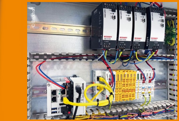
Gesteuert wird der Drucker von einem Ultra-Kompakt-Industrie-PC C6017 (L); die notwendige Energie für die sehr hohen und kurzen Stromimpulse stellen kompakte Hutschienen-Netzteile PS2001 (o.) bereit.
