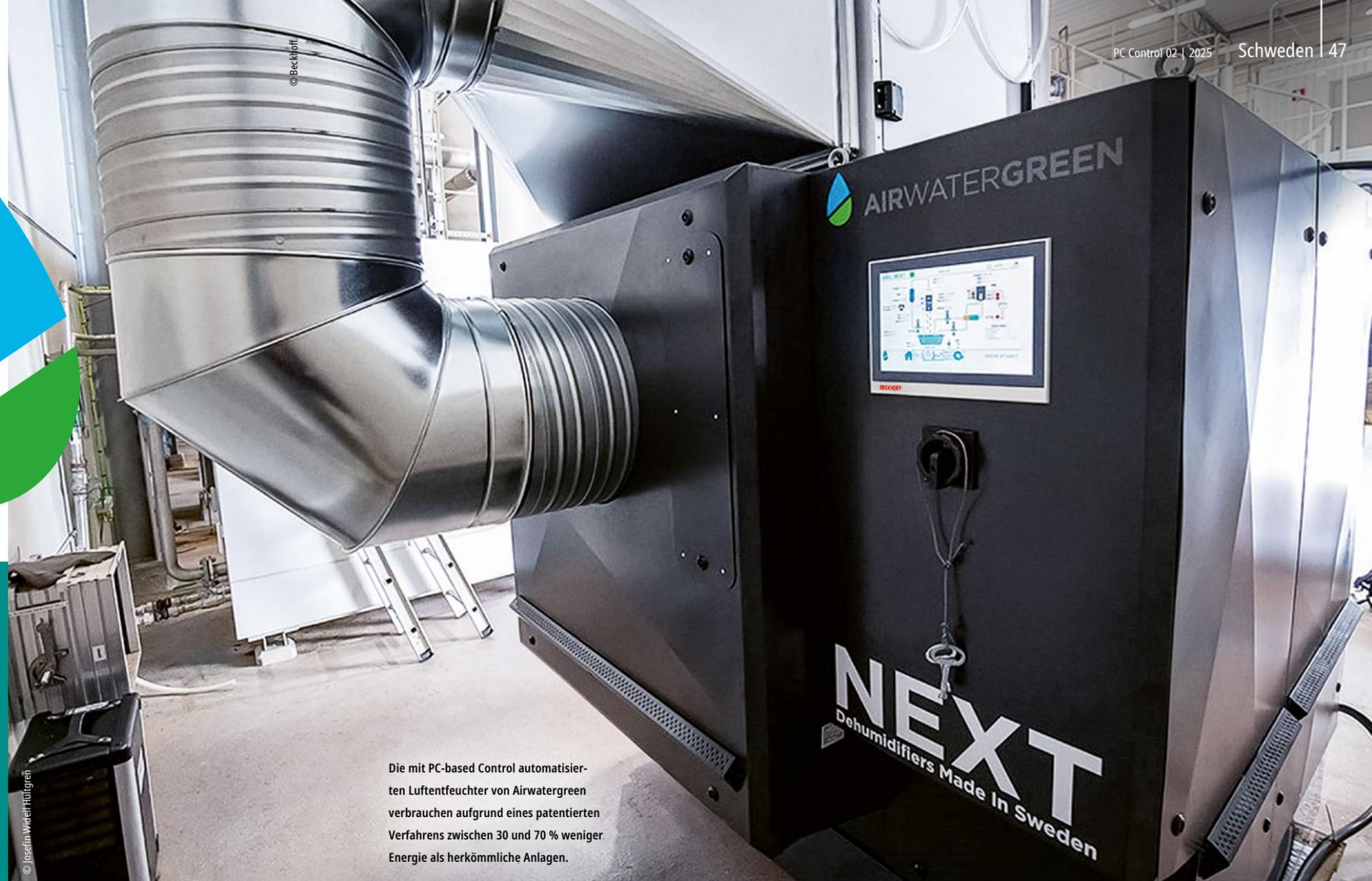
Die mit PC-based Control automatisierten Luftentfeuchter von Airwatergreen verbrauchen aufgrund eines patentierten Verfahrens zwischen 30 und 70 % weniger Energie als herkömmliche Anlagen.
