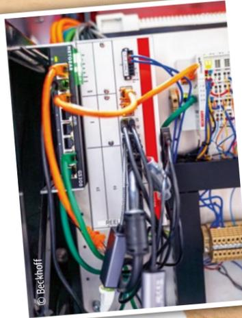
Der Schaltschrank-Industrie-PC C6930 mit der Software TwinCAT bildet den leistungsfähigen Steuerungskern der Produktionsanlage.
