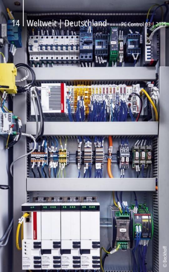
Schaltschrank der Ringsägemaschine mySaw mit dem Embedded-PC CX5240 und den angereichten EtherCAT- und TwinSAFE-Klemmen (oben) und dem Multiachs-Servosystem AX8000 (unten)
