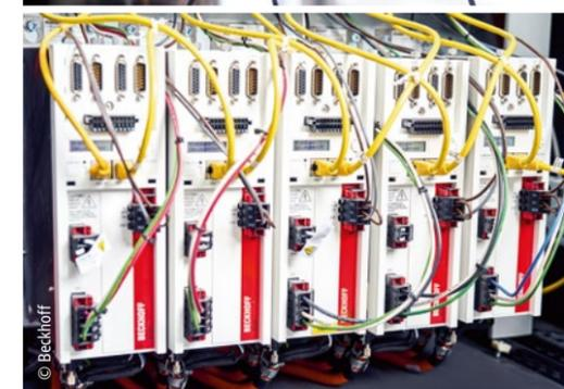
Für den Hochgeschwindigkeitsdatenaustausch mit wissenschaftlichen Spezialgeräten setzt OTI Lumionics eine Vielzahl von EtherCAT-Klemmen in der Materialtestplattform ein.
