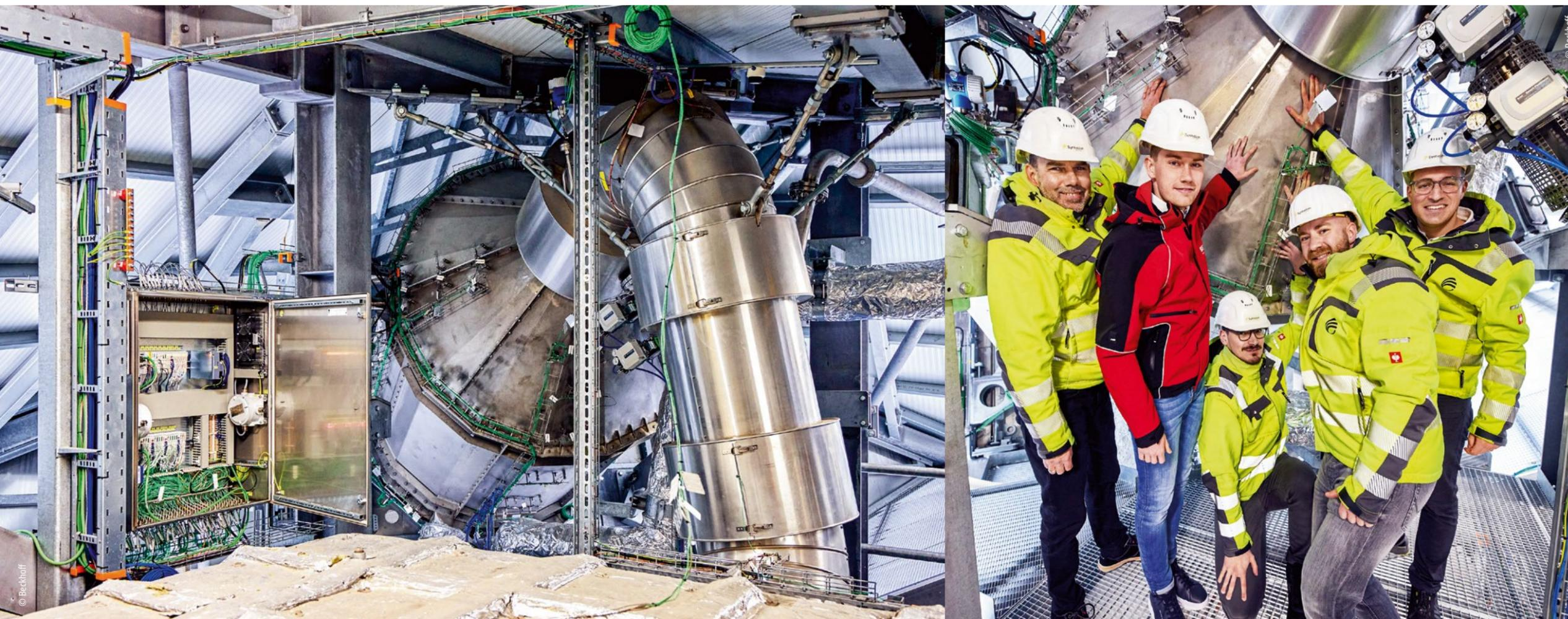
Links: Der Receiver mit 600 kW thermischer Leistung und der keramische Energiespeicher (im Vordergrund) werden über zahlreiche Thermoelemente überwacht.
