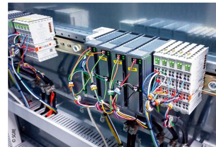
Die Hochvolt-Spannungsmessklemmen ELM3002-0205 (Mitte) im Einsatz
